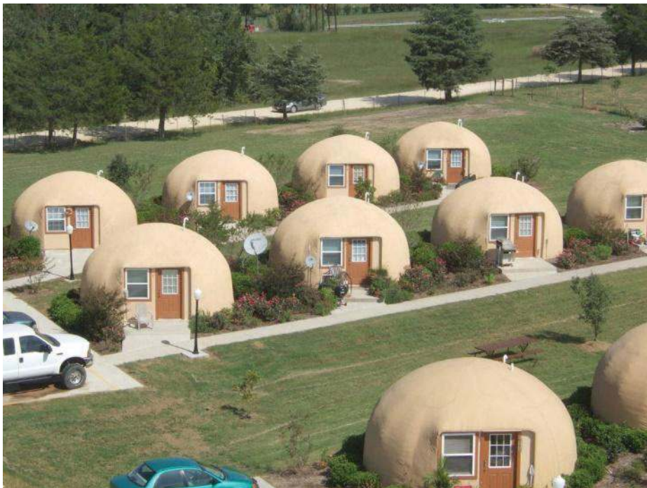
Gambar 1.7 Dome House di Ishikawa, Jepang terbuat dari styrofoam yang tahan gempa
