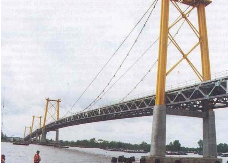
Gambar 3.6 Jembatan komposit Sumber: dpu.kulonprogo.go.id (2022)
