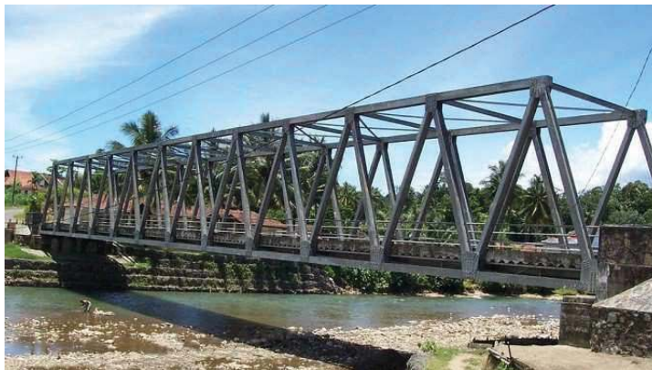
Gambar 3.10 Jembatan kerangka Sumber: steelindonesia.com (2022)
