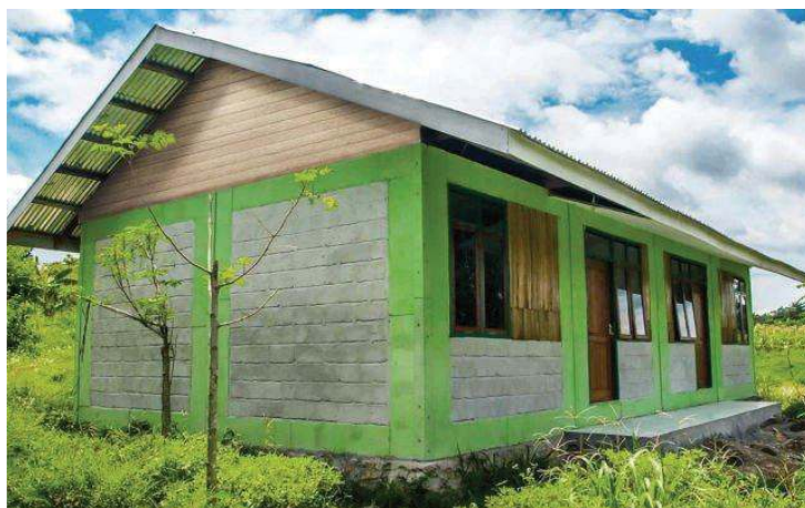
Gambar 1.5 Ruspin (Rumah Unggul Sistem Panel) Sumber: sim.ciptakarya.pu.go.id (2021)
