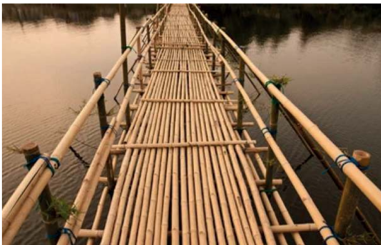
Gambar 3.7 Jembatan bambu Sumber: nty/www.123rf.com
